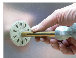
Inslaan van het spouwanker d.m.v. het slagpijpe tot aan de schotel.
