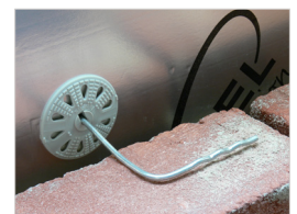
Eventueel omplooiën van het spouwanker.
